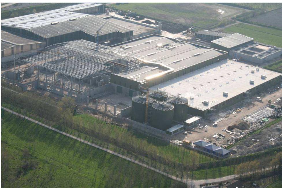
I nuovi biodigestori della prima sezione ricollocati a nord sono in acciaio, con prestazioni elevate in grado di incrementare la produzione del biogas a parità di rifiuto organico trattato, e i vecchi digestori (2 in cemento e 2 in acciaio) verranno riconvertiti in vasche di stoccaggio finale del digestato.
