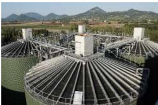
elettrica, ha una potenzialità di rifiuti effettivamente recuperati autorizzata pari a 145.000 tonn/anno (art. 9 Decreto AIA 102 del 18.12.2017). Questa sezione impiantistica è costituita da quattro impianti distinti ciascuno composto da digestore anaerobico in acciaio, completo di gasometro e torcia di emergenza
