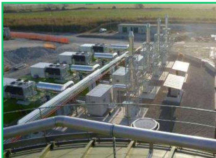
Una seconda linea di produzione di energia elettrica, indipendente dalla precedente, ma con gli stessi principi di funzionamento è composta da quattro digestori anaerobici indipendenti, ciascuno dei quali va ad alimentare il proprio gruppo di cogenerazione, della casa costruttrice Jenbacher con potenza cadauno di 998 kW/h. (BIO1, BIO2, BIO3, BIO4).
