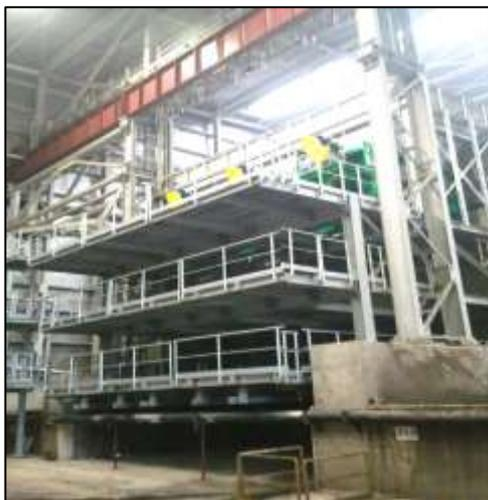
La sezione di pretrattamento meccanico detta “aprisacco, vagliatura e mulini vagli” è organizzata in tre torri, ciascuna con tre linee di trattamento parallele realizzate in assetto verticale con trituratore-lacera sacchi e due mulini/vagli, una di supporto all’altra nel caso di fermo macchina per manutenzione e/o nella lavorazione di rifiuti in ingresso con diversa qualità.
